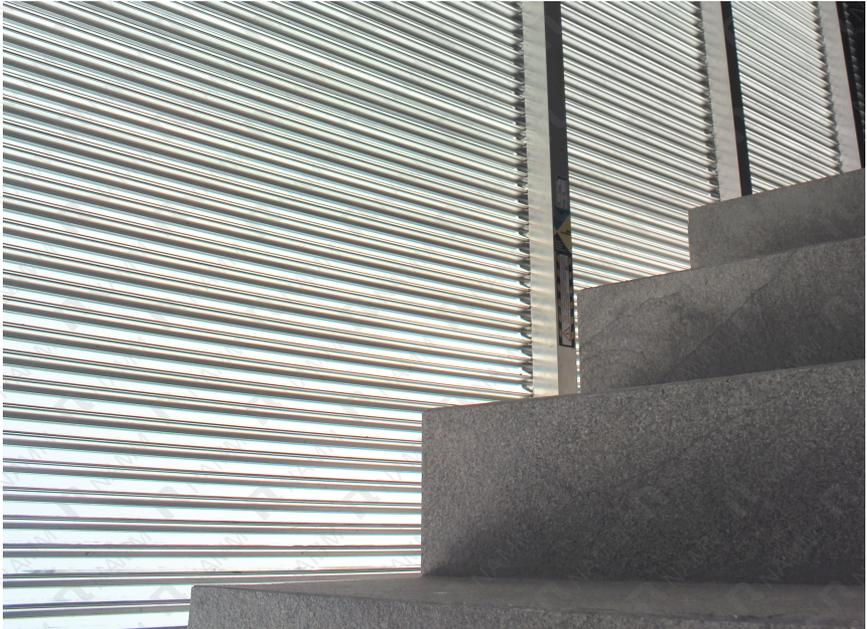
En este edificio se colocaron Louvers para ventilar escaleras de emergencia sin comprometer el diseño arquitectónico.
